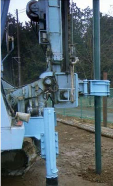
支持地盤の確認と打ち止め管理は、調査データより、各パターンを想定し、貫入速度および回転トルク値を計測することにより、確実に設計支持力が期待できるように管理しています。また、非常に堅固な地盤に貫入する場合、長時間にわたる回転貫入は支持地盤を乱し、支持力が低下する場合があります。これを実験により証明し、打ち止め管理方法を定めています。
